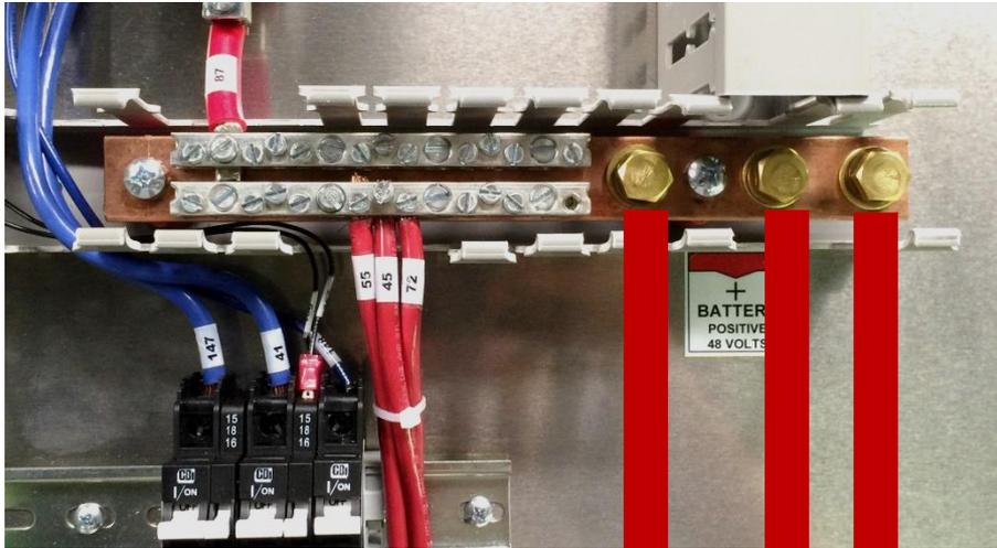
Les cables + batterie sont sur le BUS BAR +.
