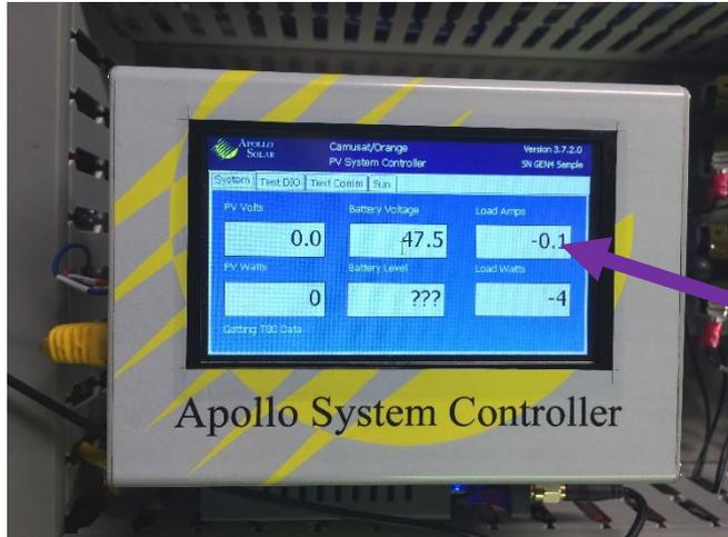
L'ASC utilise un écran tactile LCD pour l'interface utilisateur. Les fenêtres de l'écran donnent à l'installateur l'information qui lui permet de facilement tester chaque fonction et vérifier le fonctionnement du système.
